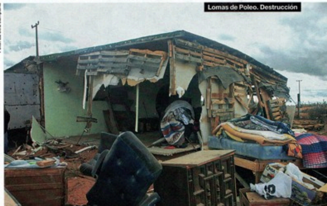
Lomas de Poleo. Destrucción
